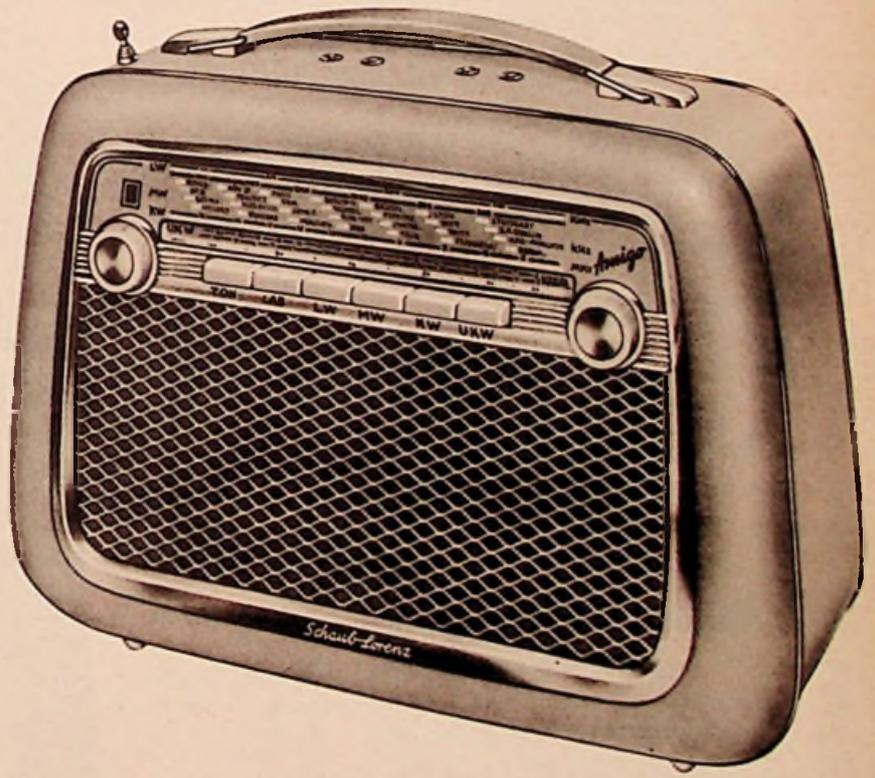
Spitzenempfänger mit fest eingebautem Heizakku und 17 (7 + 10) Kreisen für UKW, Kurz, Mittel und Lang. 7 Röhren, 2 Ge-Dioden, 1 Duplo-Trockengleichrichter, Groß-
